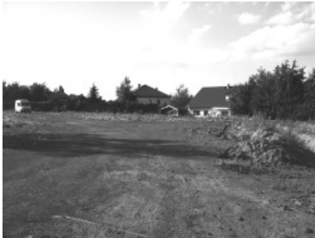
Abbildung 14: Neubaugrundstück Kita B Kesselsdorf (Quelle: eigene Aufnahme)
